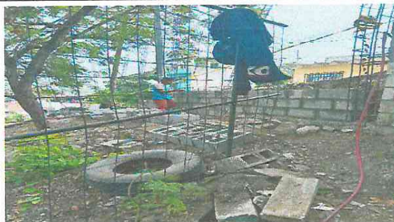
Foto 4: trabajo y seguimiento del muro perimetral
