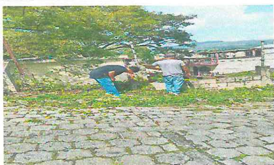
Foto1: Inicio de los trabajos del muro perimetral
