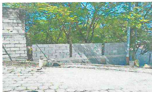
Foto 5: avances del muro perimetral
