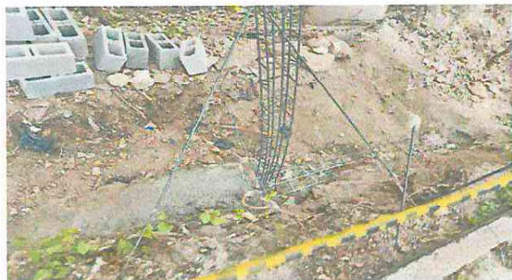
Foto 3: trabajos de levantado de muro perimetral
