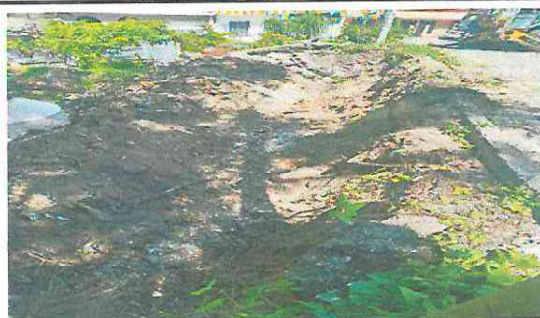
Foto 2: quitado de malla e inicio de sanjeo
